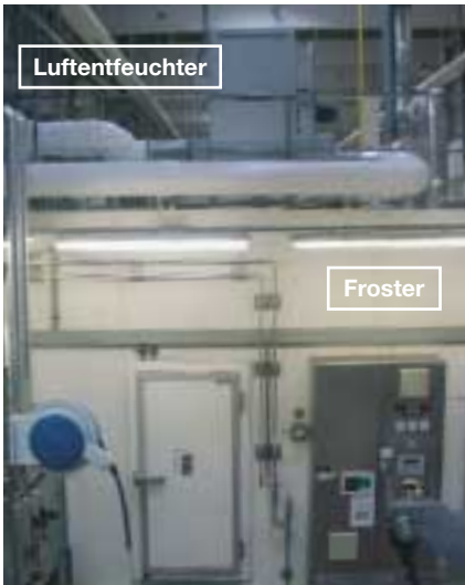
Der Munters Luftentfeuchter wurde auf dem Froster installiert.
